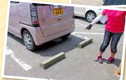
車椅子駐車場なのに車の後ろから車椅子が降ろせない駐車場
