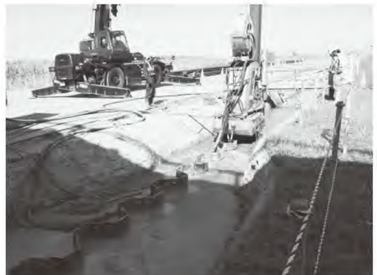
堤防耐震工事
