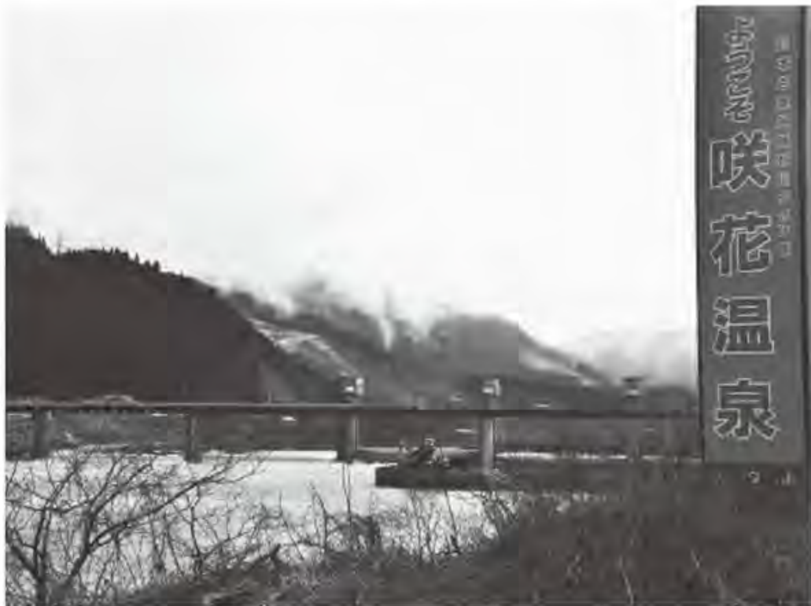
阿賀野川頭首工
