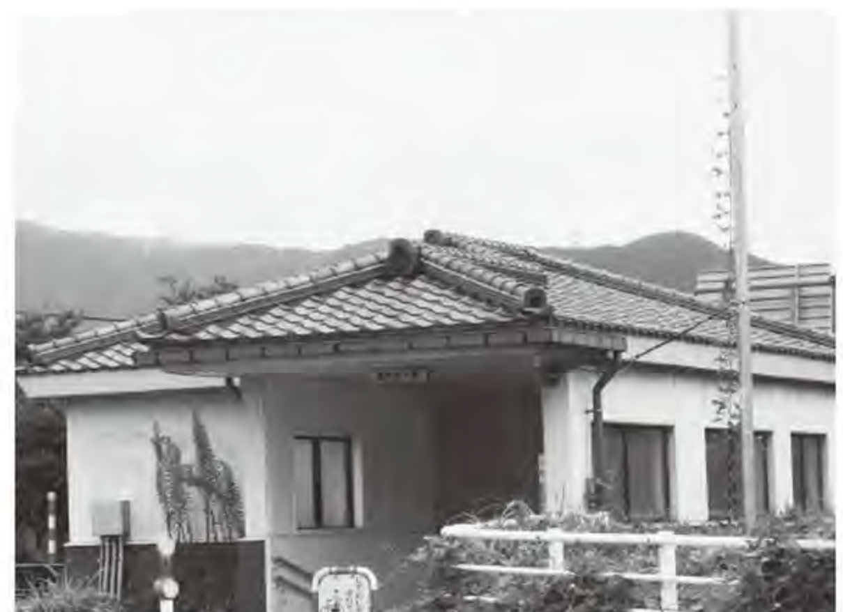
横断地下道入口
