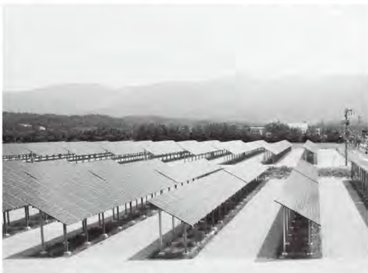
太陽光発電所
