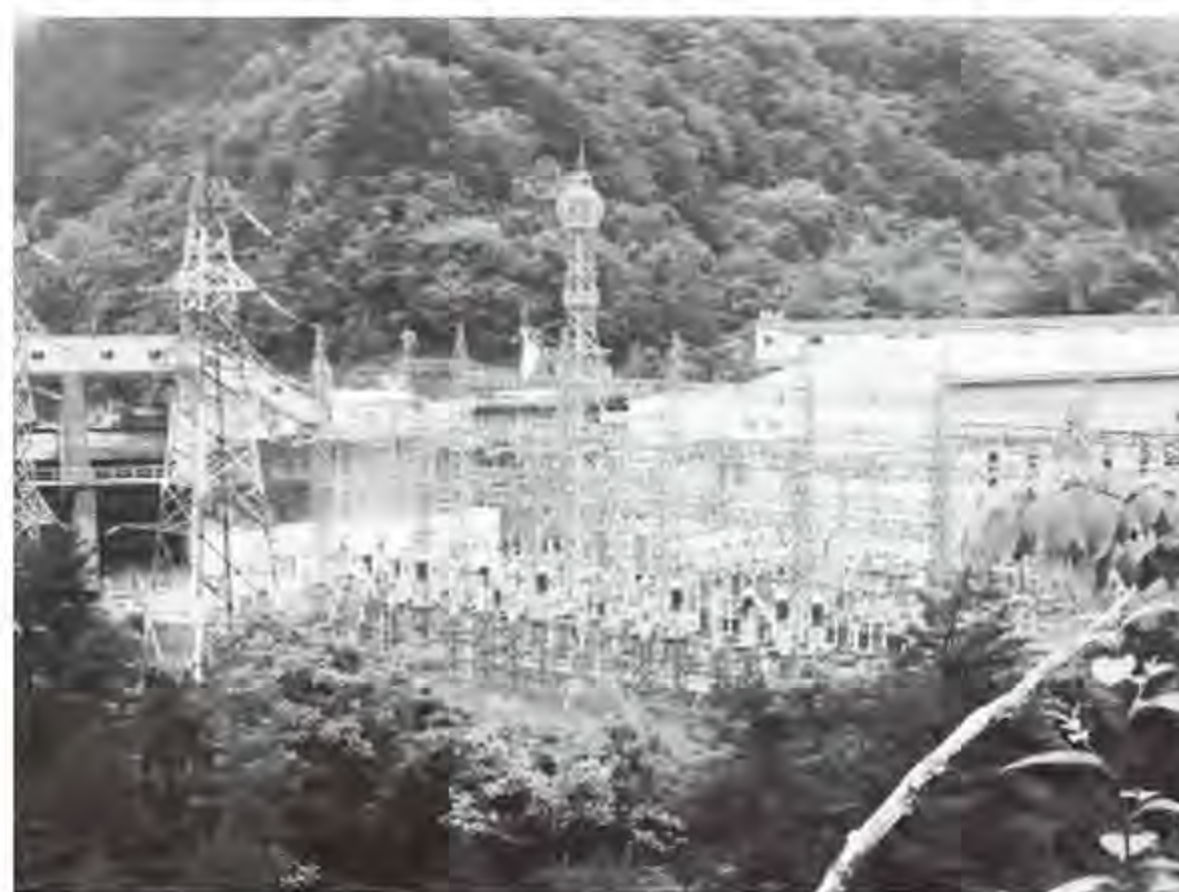
阿賀町鹿瀬水力発電所
