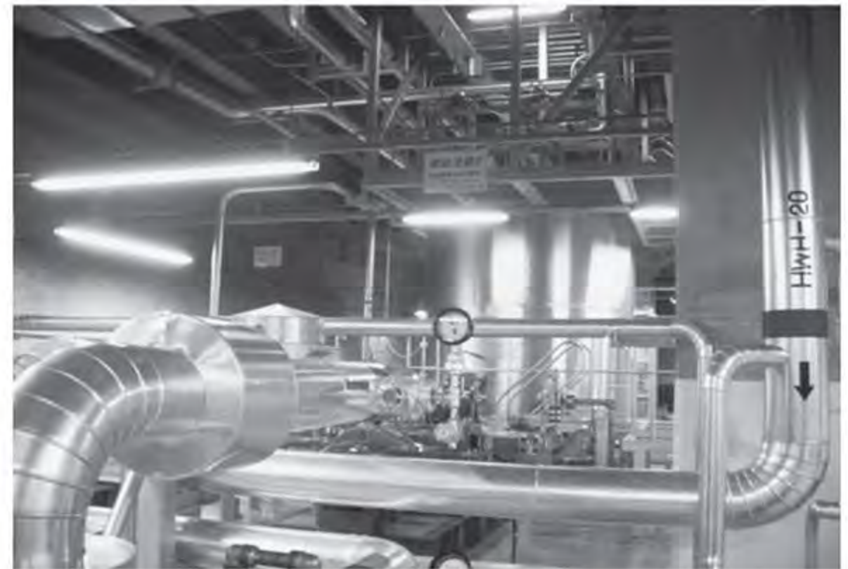
柏崎刈羽原発のホウ酸注入装置
